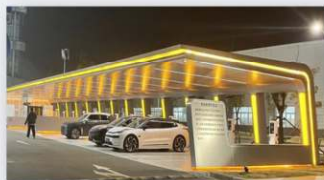
“风光荷储充”综合能源生态示范站
